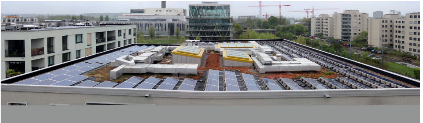
Abb. 7: Die Lüftungstechnik beansprucht wertvolle Dachfläche, die dann nicht für die Erzeugung von Solarstrom genutzt werden kann. (Foto: Lemon Consult)
