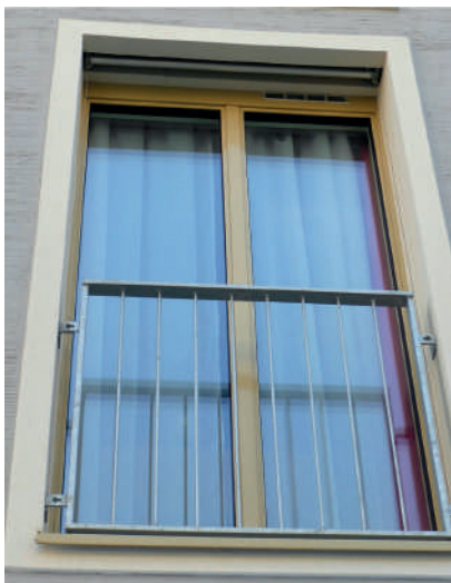
Abb. 4: Bei der Abluftanlage strömt die Aussenluft über Lüftungsschlitze in der Fassade in die Räume ein. Die Aussenluftdurchlässe sind im Fensterrahmen oben sichtbar. (Foto: Lemon Consult AG)
